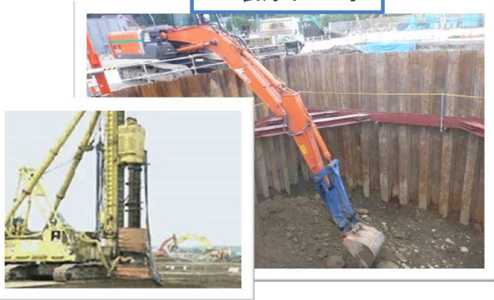
土壌浄化工事
