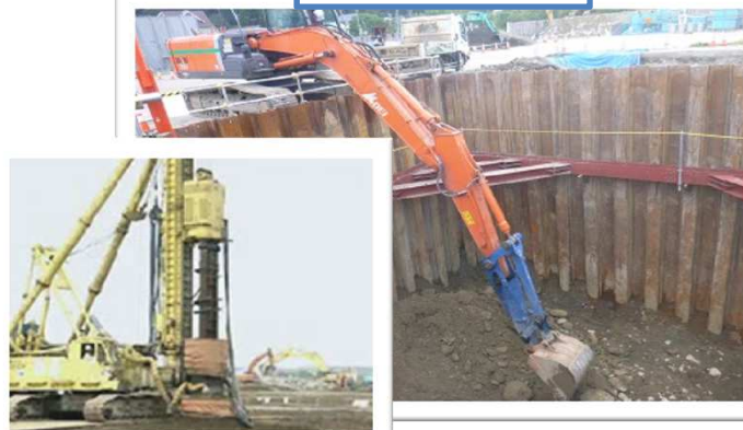
土壌浄化工事
